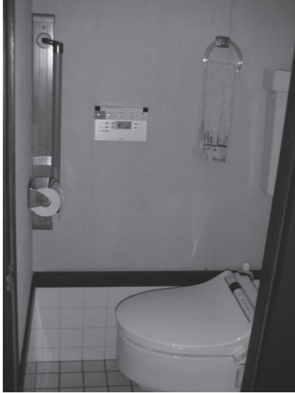
写真1 「事例1」 トイレ回り改修部
