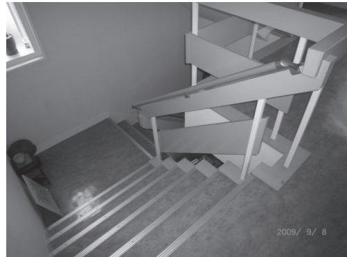
写真4 [事例2] 階段、トイレ回り改修部
