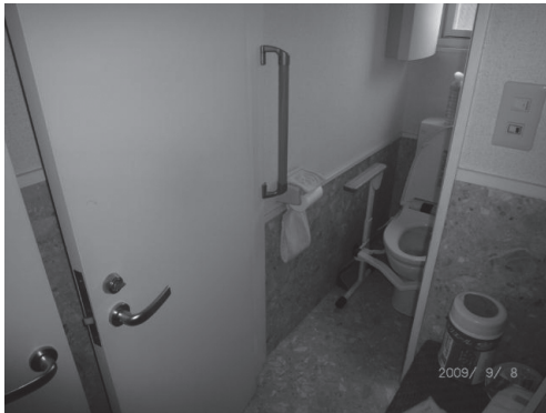
写真3 [事例2] 階段、トイレ回り改修部
